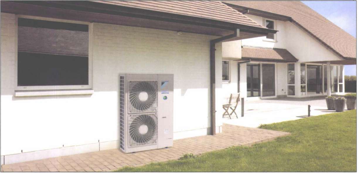
Şekil 5.93. MİNİ VRV SİSTEM UYGULANMIŞ VİLLADA DIŞ ÜNİTE YERLEŞİM ÖRNEĞİ
