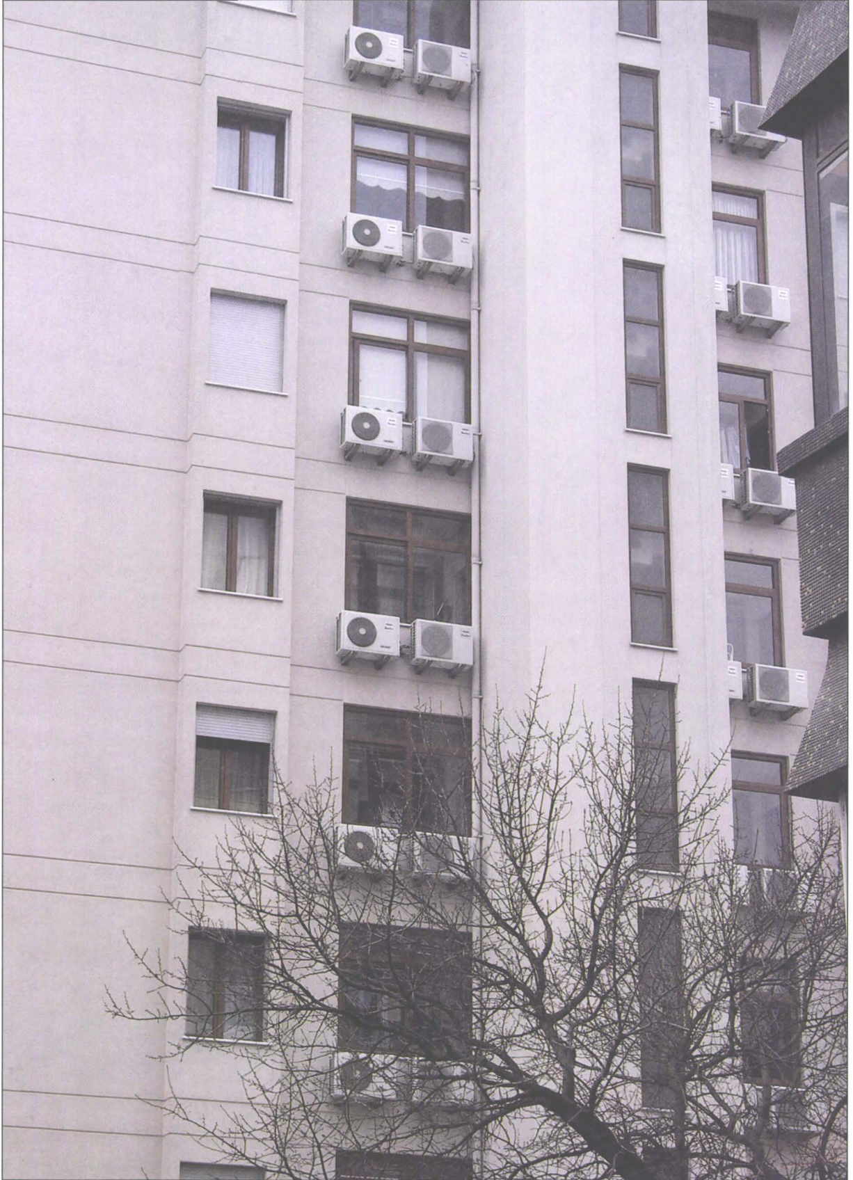
Şekil 5.3. MİNİ SPLİT DIŞ ÜNİTE YERLEŞİMİ DÜZENLİ YERLEŞİM (SERVİS TEKNİSYENİ İÇİN RİSKLİ)
