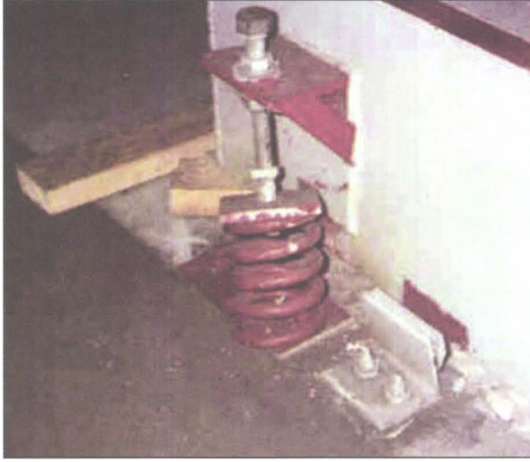
Şekil 13.9. AÇIK İZOLATÖRLERLE BİRLİKTE KULLANILMAK ÜZERE SEÇİLMİŞ ANCAK GEREĞİNDEN KÜÇÜK BOYUTLANDIRILMIŞ SİSMİK SINIRLANDIRICILAR SEBEBİYLE POMPA ŞAŞİSİNDE HASAR OLUŞUMU
