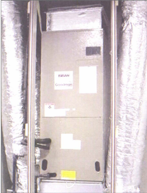
Şekil 5.21. DÖNÜŞ HAVA KANALLI UYGULAMA
