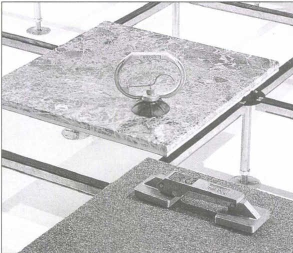
Şekil 8.17. YÜKSELTİLMİŞ DÖŞEME KONSTRÜKSİYONU
