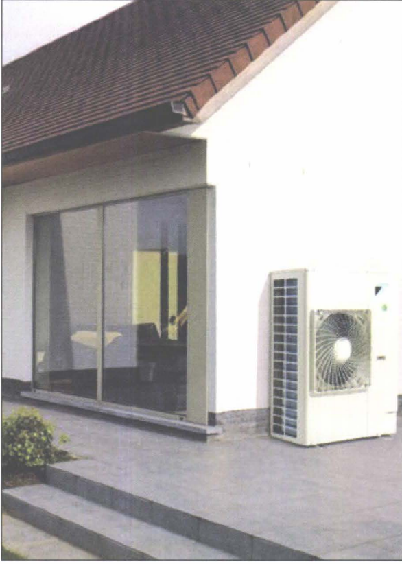
Şekil 9.10. MİNİ VRV DIŞ ÜNİTE UYGULAMA ÖRNEĞİ
