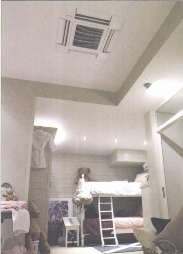
Şekil 9.12. MİNİ VRV KASET TİPİ İÇ ÜNİTE UYGULAMA ÖRNEĞİ
