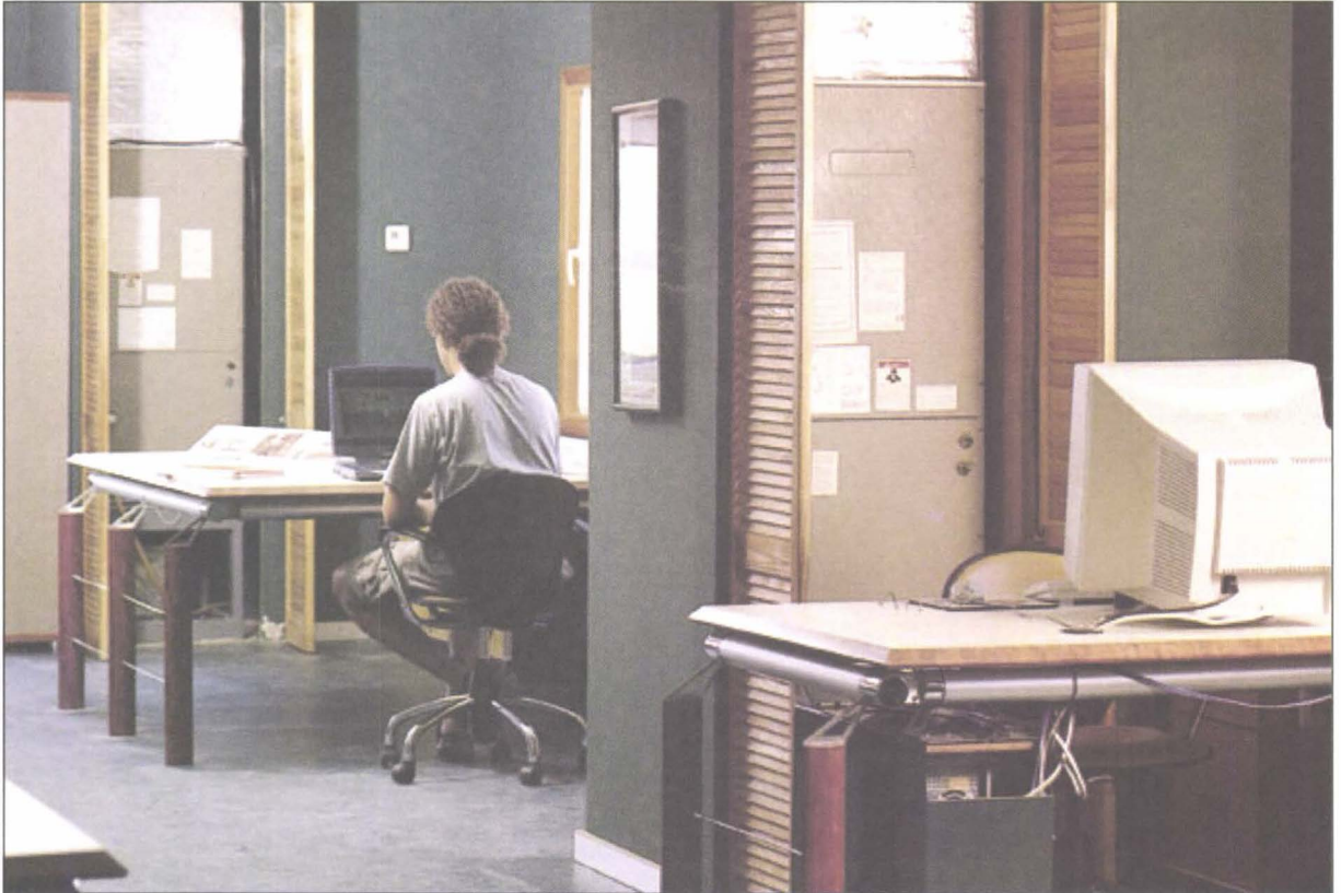
Şekil 4.23. OFİS UYGULAMA ÖRNEĞİ KANAL TİPİ KLİMA AÇIK OFİSTE ORTAMDA
