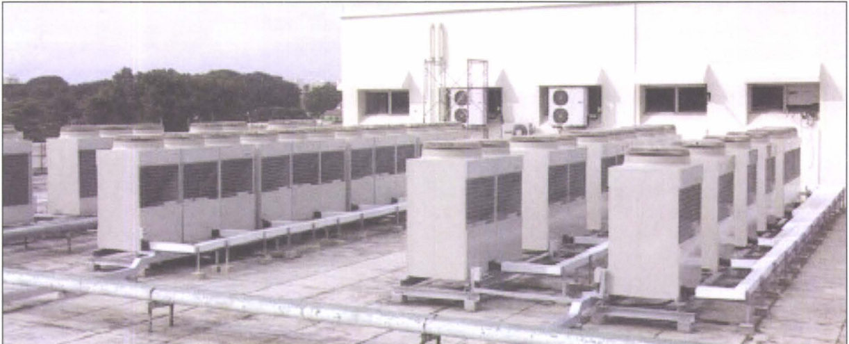
Şekil 5.88. VRV DIŞ ÜNİTELER ZEMİN UYGULAMASI
