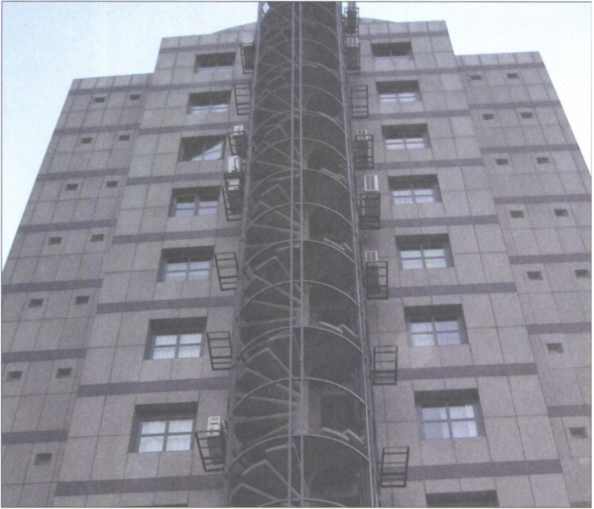
Şekil 5.15. MULTİ SİSTEM UYGULAMASI DIŞ ÜNİTELER, ZOR SERVİS (SERVİS TEKNİSYENİ İÇİN TEHLİKELİ. YANGIN MERDİVENİNE MONTAJ DA DOĞRU DEĞİL)
