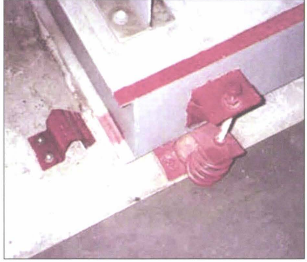
Şekil 13.9. AÇIK İZOLATÖRLERLE BİRLİKTE KULLANILMAK ÜZERE SEÇİLMİŞ ANCAK GEREĞİNDEN KÜÇÜK BOYUTLANDIRILMIŞ SİSMİK SINIRLANDIRICILAR SEBEBİYLE POMPA ŞAŞİSİNDE HASAR OLUŞUMU
