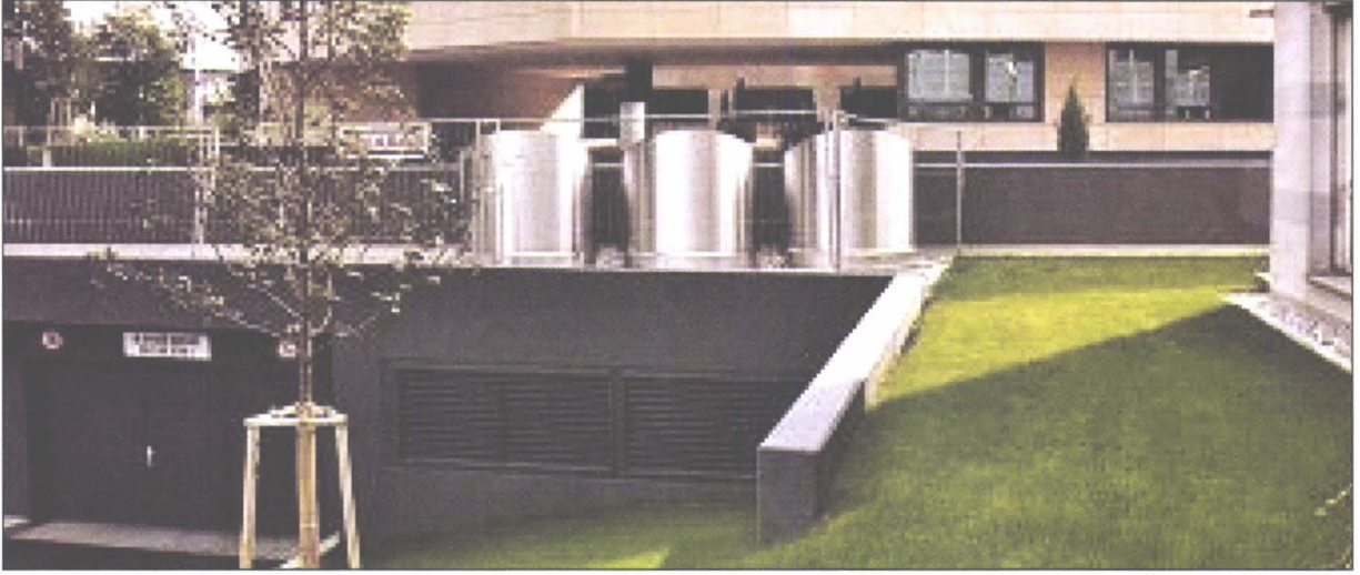
Şekil 5.92. TESİSAT MERKEZİNDEKİ DIŞ ÜNİTELERE DIŞARDAN HAVA KANALI BAĞLANTISI
