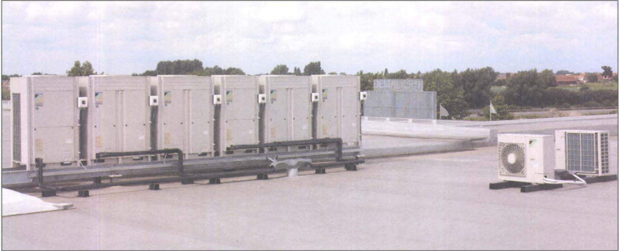
Şekil 5.87. VRV DIŞ ÜNİTELER ÇATI UYGULAMASI
