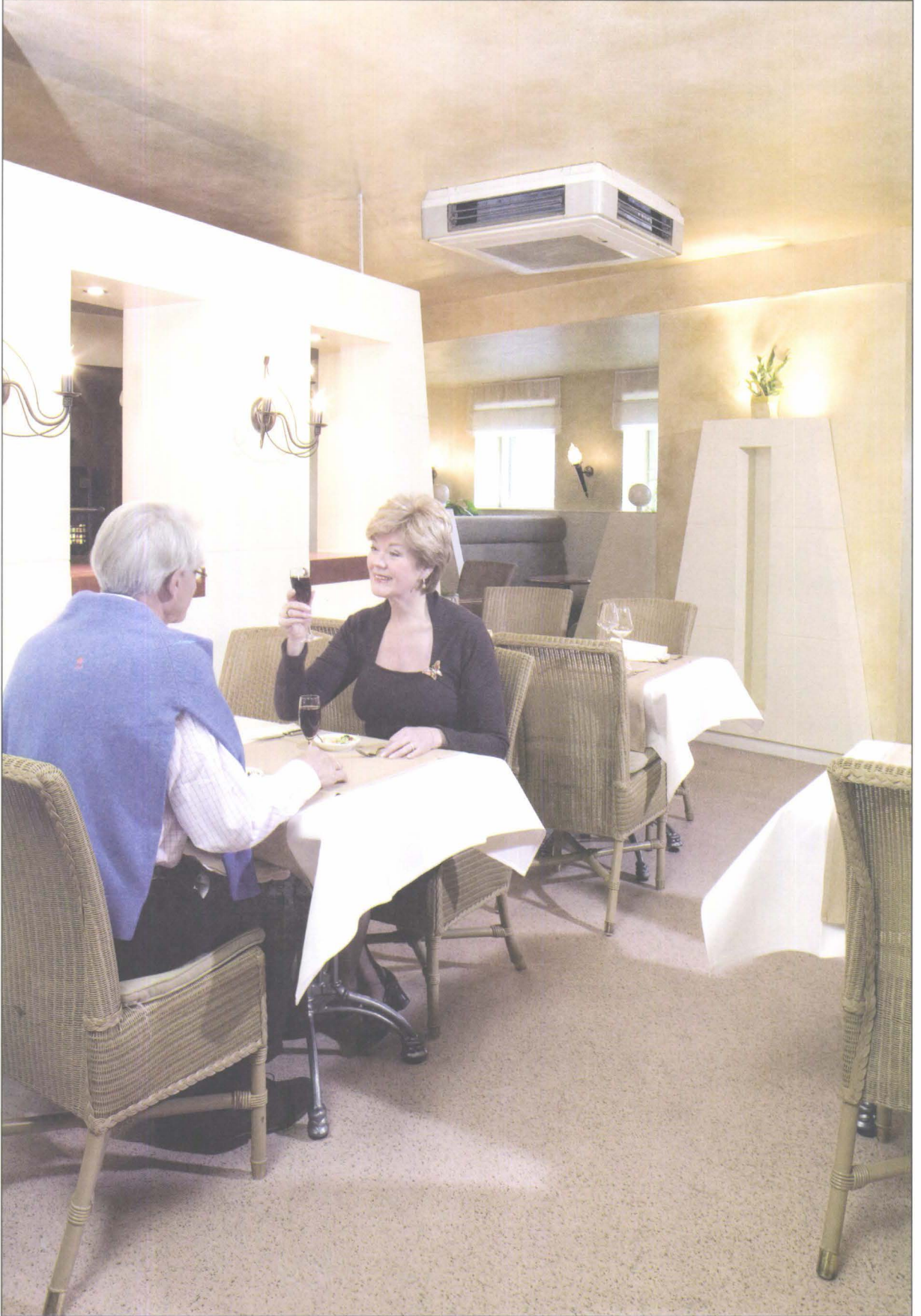
Şekil 5.9. DÖRT YÖNE ÜFLEMELİ ASILI TAVAN TİPİ SPLIT KLİMA UYGULAMASI
