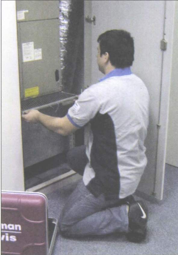
Şekil 5.23. DÖŞEMEYE MONTE EDİLEN SPLIT KLİMA İÇ ÜNİTELERİNDE BASİT VE HIZLI FİLTRE TEMİZLİĞİ YAPILABİLİR.
