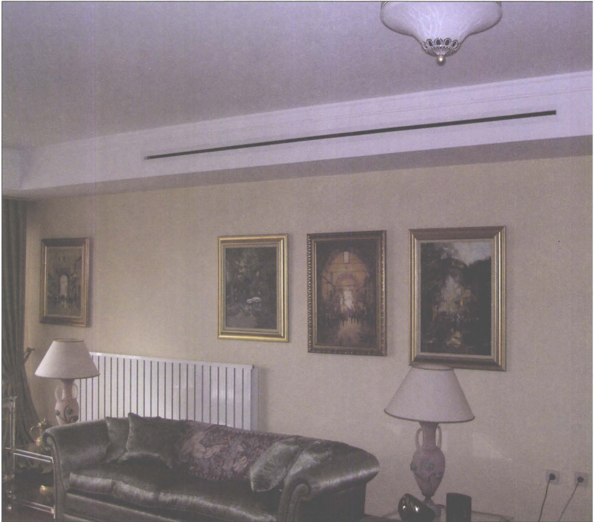
Şekil 5.36. Trio Konutları DAİRE-SLOT DİFÜZÖR
