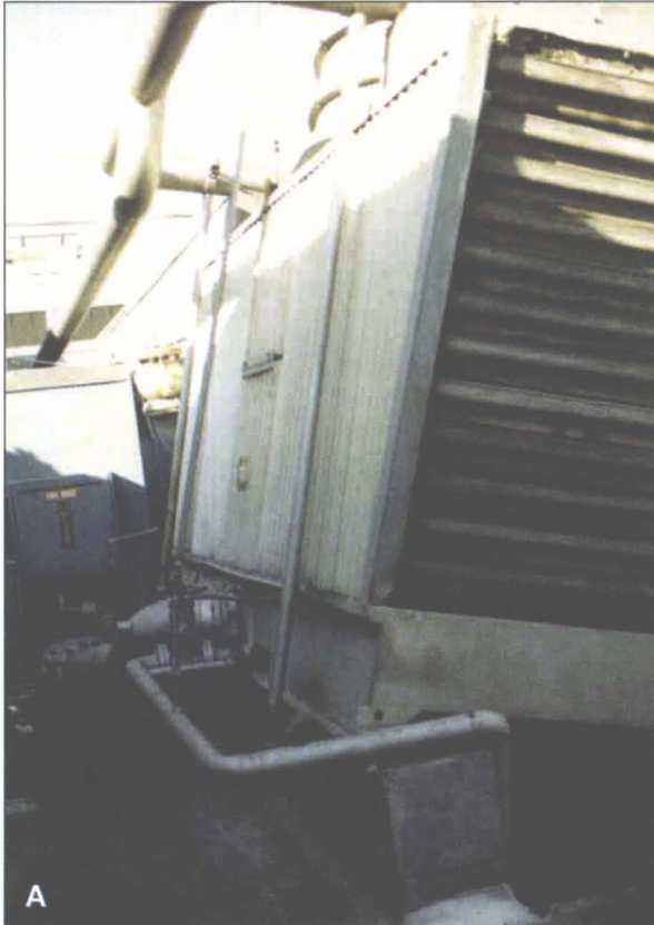
Şekil 13.6. DEPREM KORUMASI YAPILMAMIŞ TESİSAT DONANIMLARINDA HASAR OLUŞUMU
