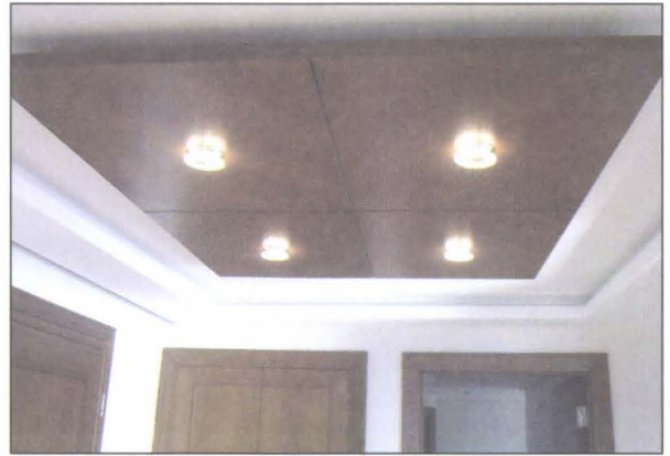
Şekil 5.24. GİZLİ TAVAN TİPİ İÇ ÜNİTEYE SERVİS HİZMETİ, YERE MONTAJA GÖRE DAHA ZOR YAPILIR. Dekorasyonda kapak detayları, servisin kolay yapılabileceği boyutlarda olmalı ve kolay sökülüp takılabilmelidir.
